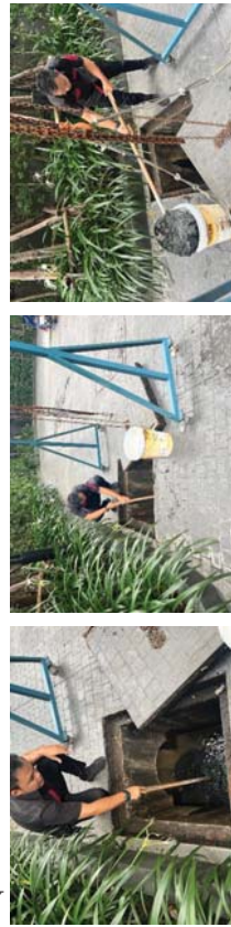
การดูดลอกบ่อหนั่งน้ำและการระบายน้ำ
