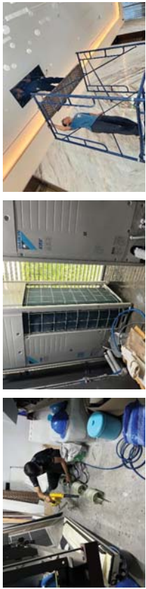
กำลังทำความสะอาดเครื่องปรับอากาศ
